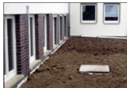
Fertig: Die Grube ist wieder verfüllt.
