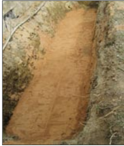
Das Sandbett ist für den Behälter fertig.
