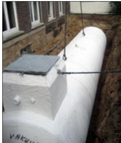
Passt genau: Der Tank im Boden.
