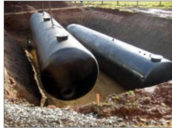
Einlagerung zweier Erdtanks mit einem Gesamtvolumen von 200.000 Litern – Löschwasser für ein Flüssiggaslager in der Region.
