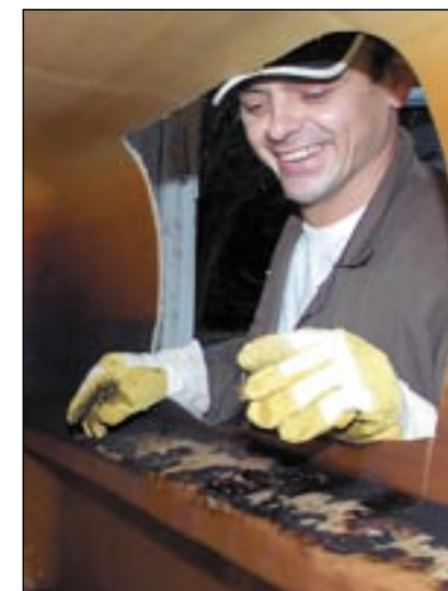
Geht fröhlich ans Werk: Viktor Maier ist unter anderem für den Ausbau alter Tanks zuständig.
