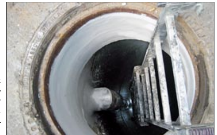
Blick in den Schacht eines Ölabscheiders.
