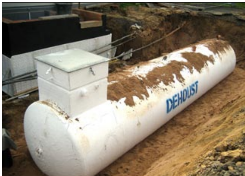
Am Standort Gemünden tauschte die Firma Walter für den Auftraggeber Ferrero einen 30.000 Liter fassenden Tank aus.
