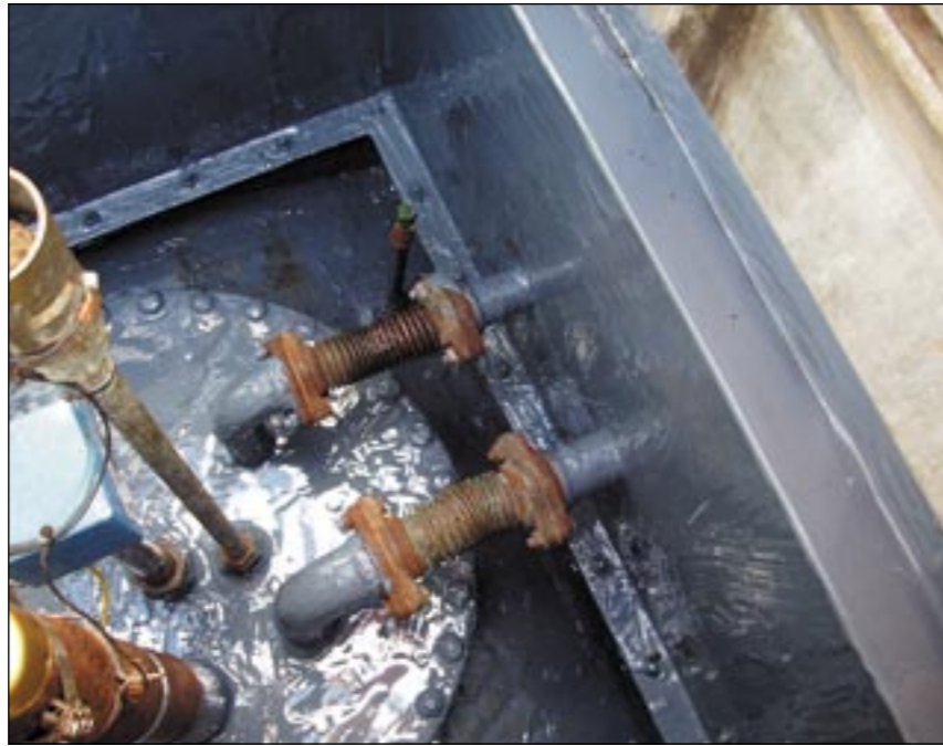
In diesem Jahr öfters gefragt: Sanierung von Benzintanks durch Einbau einer zugelassenen Leckschutzauskleidung. Dabei wurden auch die Domschächte überarbeitet und neu beschichtet.
