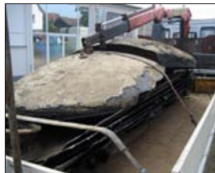
Alte Tanks wurden in Einzelteile zerlegt und abtransportiert.
